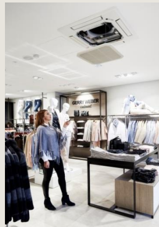
In wenigen Sekunden gleitet die Filterkassette um bis zu 4 m nach unten.
