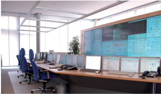
**Bild 3:** Eine Großbildprojektionswand unterstützt die Bedienführung und liefert Prozessübersichten und Videoeinblendungen auf einen Blick. Die offenen Strukturen des Leitsystems PMSX®pro ermöglichen die Kopplung zu SAP/R3 und zu übergeordneten Hierarchien.
