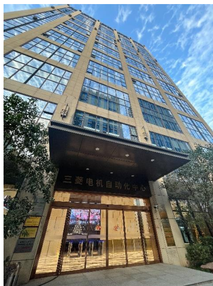
Mitsubishi Electric Automation (China) Ltd. mit dem Collaborative Engineering Center (China) am selben Standort
