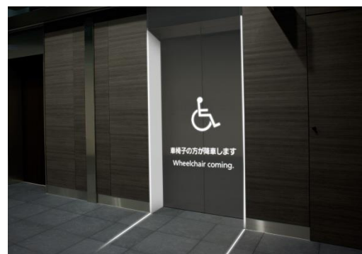
Wegweisende Projektionsanzeigen auf der Aufzugstür
